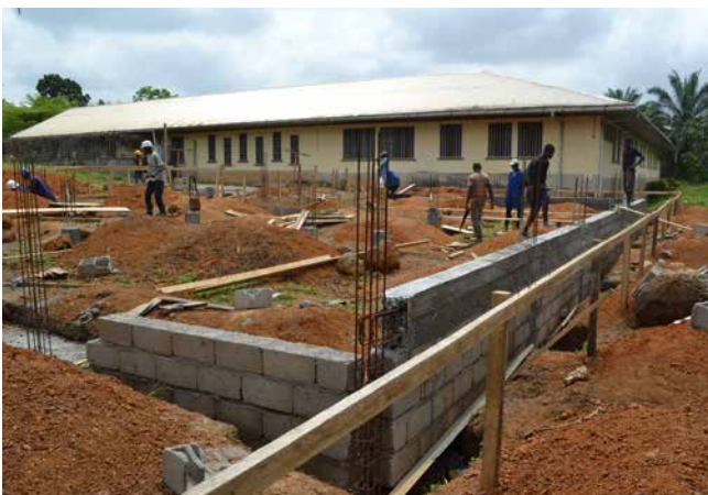
Baustelle im Noviziat
